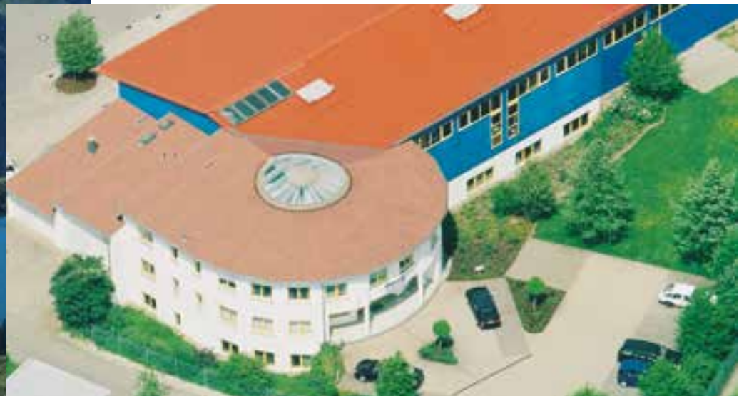
Das Firmengebäude der Pfennig Reinigungstechnik in Durach
