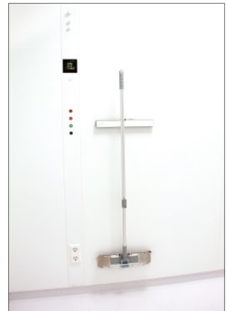
Abb. 5: Wandhalterung mit den Komponenten „seitliche Halterung für Mopphalter“ vom Reinigungswagen
